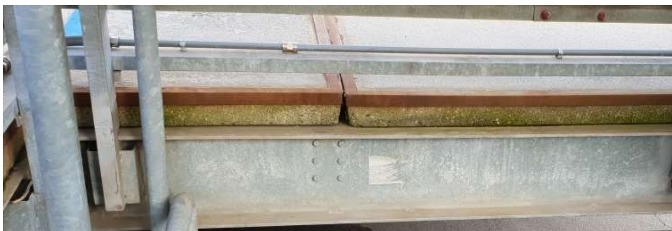
fig. 2 – le lastre prefabbricate dell'orizzontamento
